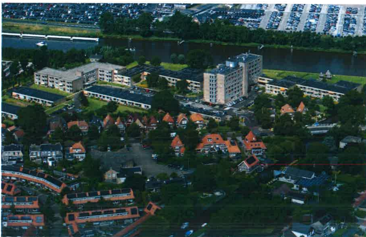
Luchtfoto Almenum, juni 2022, in Harlingen, fotograaf Joachim de Ruijter
