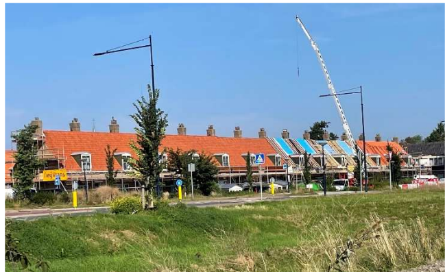
Planmatig onderhoud isoleren daken Kimswerderweg
