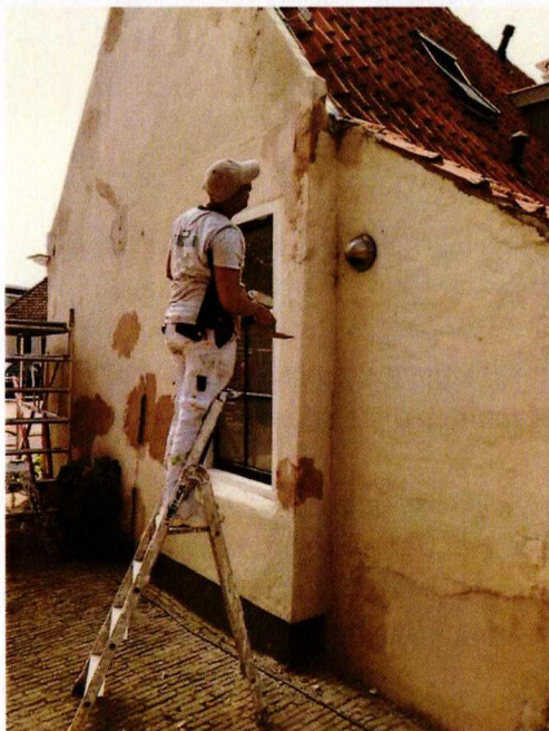
Herstel stucwerk bij Kerkpad
