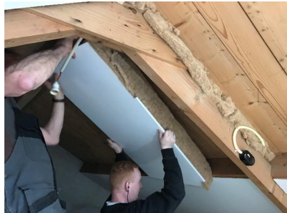
Hette Wever brengt dakisolatie aan in P.J. Troelstrastraat
