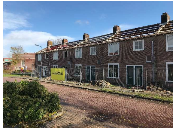
Wilhelminastraat sloop daken / asbest verwijderen
